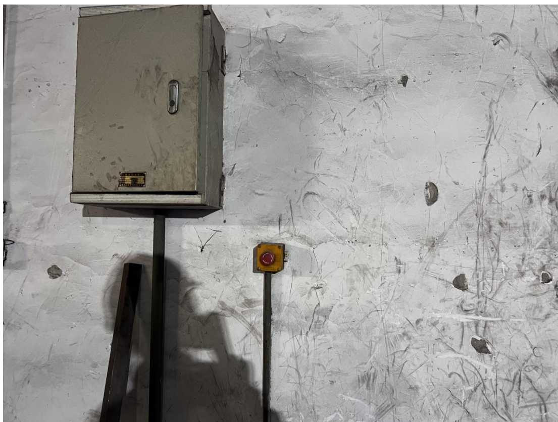
图 7 探伤室内急停按钮
